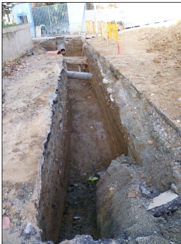
Fotografia 13. Vista general Rasa 5
