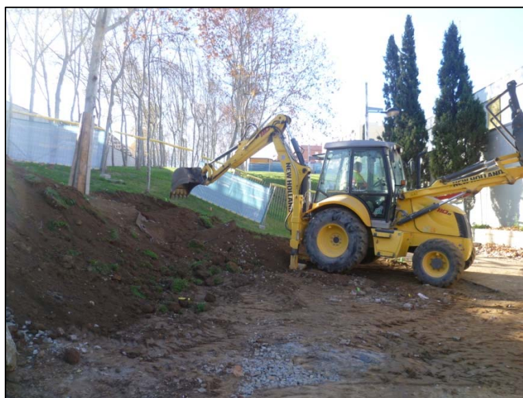
Fotografia 16. Rebaix del talús
