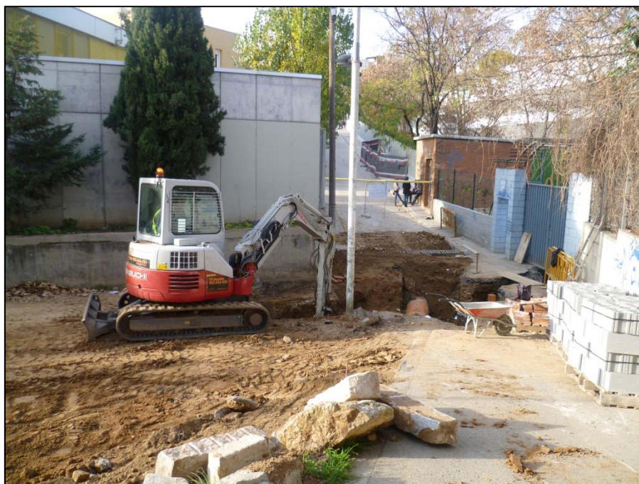
Fotografia 10. Obertura del Pou 2
