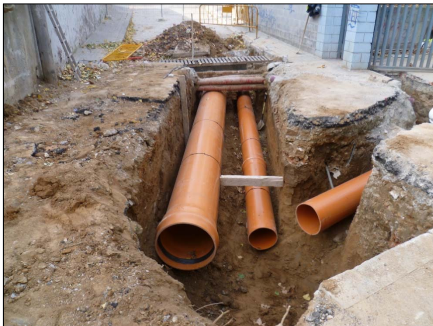
Fotografia 9. Instal·lació de les tubulars a les rases 3 i 4
